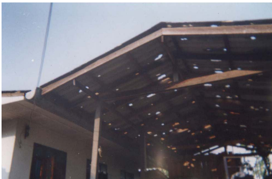
ภาพลูกเห็บตกใส่หลังคารายกร จังหวัดเชียงราย
