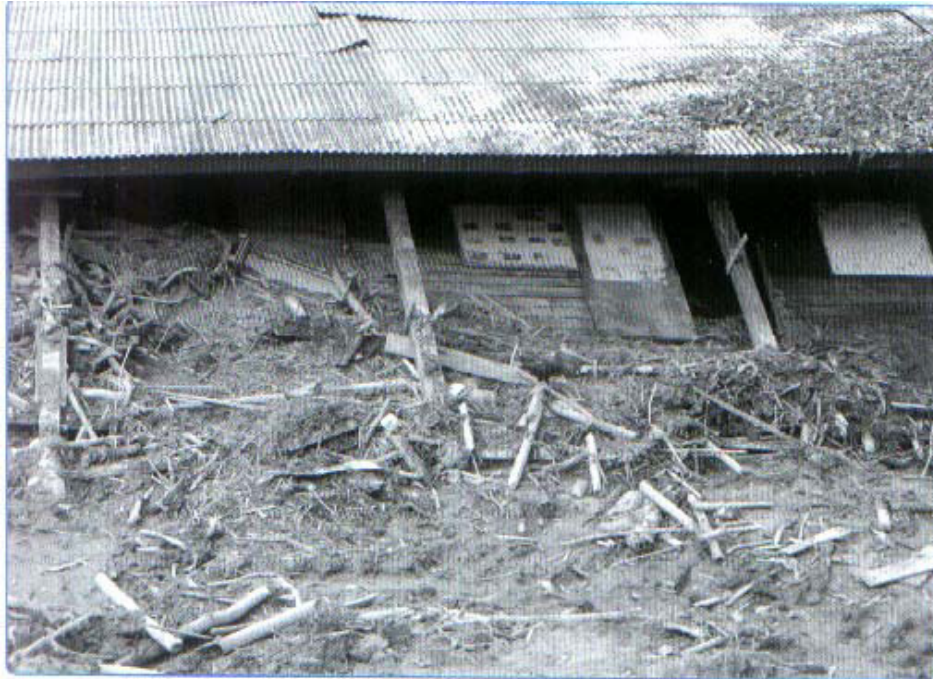
โคลนถล่มอาคารเรียน อ.วังจีน จ.เพชรบูรณ์
