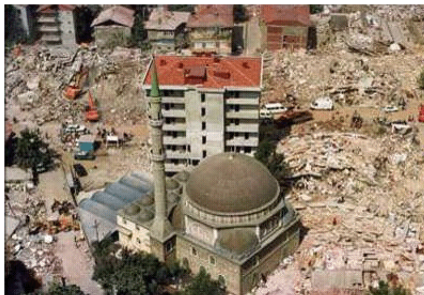
อาคารที่มีโครงสร้างไม่แข็งแรงเมื่อเกิดแผ่นดินไหวจะเกิดอาคารถล่ม
