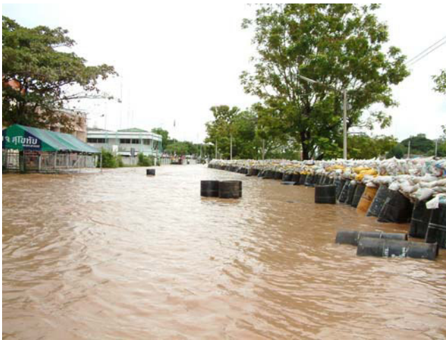
เสริมคันกันน้ำด้วยกระสอบทราย
